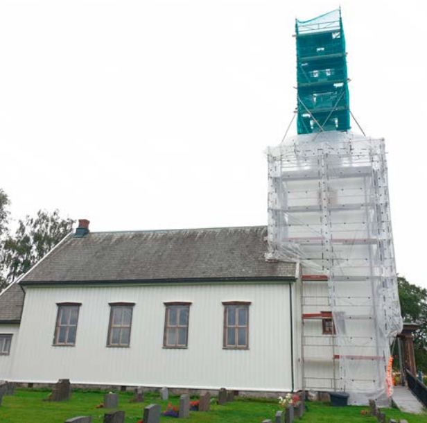
Reparasjon av tårnet i Kroer Kirke. Foto: Monica Lislrud.
