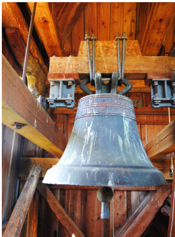
Ill. 5: Sauherad kirke, Telemark. Eksempel på klokke som er montert i vinkelaksel. Denne måten å henge opp kirkeklokker på har fått en viss utbredelse siden slutten av 1800-tallet. FOTO: TERJE DE GROOT.
