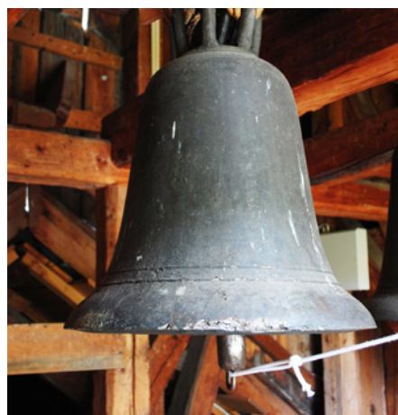
Ill. 32: Ved enkeltslag, kiming og klemting henger klokken stille, mens kolben slår mot slagringen. Illustrasjonsfoto fra Veggli kirke i Buskerud, hvor man slår enkeltslag ved hjelp av et tau festet i kolben. FOTO: TERJE DE GROOT.
