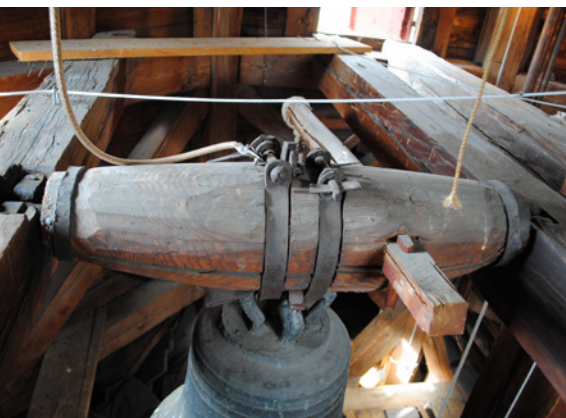
Ill. 6: Flesberg stavkirke, Buskerud. Akseltapp med smidd lagerleie direkte innfelt i treverk. FOTO: TERJE DE GROOT.
