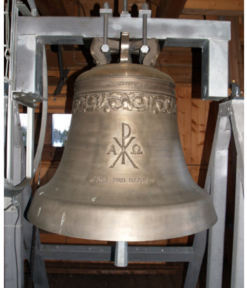
Ill. 29: Holmenkollen kapell, Oslo. Den minste av de to klokkene, som begge er støpt i 1995 med den såkalte sanctusrippen, klokkefasongen som Olsen Nauen klokkestøperi tok i bruk omkring 1934. FOTO: TERJE DE GROOT.
