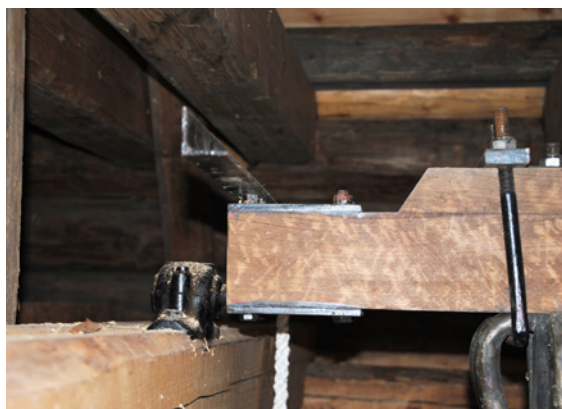
Ill. 10: Tretten kirke, Oppland. Eksempel på klokke hvor akseltappen er innfelt i moderne kulelager. Kulelagre er den sikreste opplagringen av kirkeklokker og sørger for at klokken svinger jevnt. FOTO: TERJE DE GROOT.
