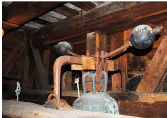
Ill. 11: Dale kirke, Luster, Sogn og Fjordane. Eksempel på balanseringeapparat. Legg merke til at akselen ikke har tradisjonelle tapper, men «kniver» som vagger i stålpanner sikret med metallbøyle. Det skal aldri være olje i stålpannen, men man kan helle litt sand i den for å stabilisere «kniven». FOTO: TERJE DE GROOT.
