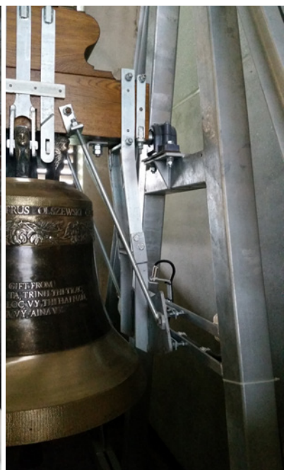
Ill. 35: Klokke med lineærmotor, som bruker magnetfelt istedenfor wire eller reim for å sette klokkene i sving. Eksempelbilde fra St. Gudmund katolske kirke på Jessheim, Akershus. FOTO: TERJE DE GROOT.
