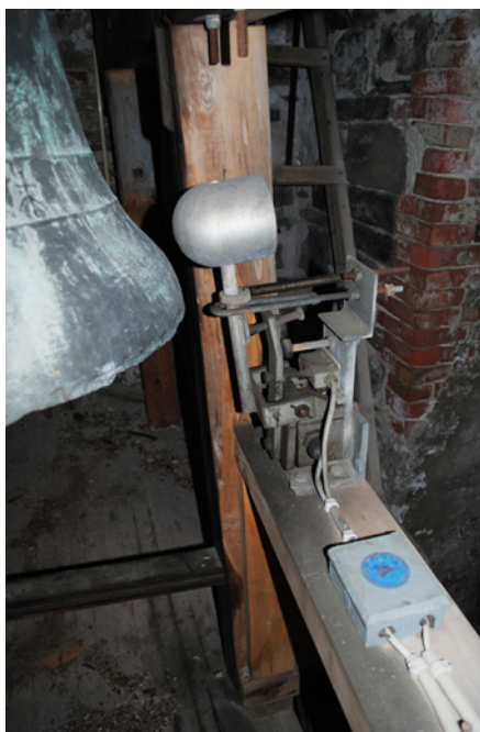
Ill. 34: Automatisk hammer til enkeltslag, kiming og klemting. Dette eksemplet er hentet fra Orkdal kirke, Sør-Trøndelag. FOTO: TERJE DE GROOT.
