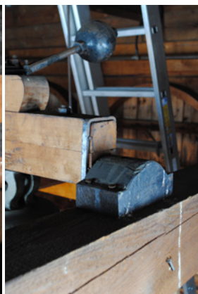
Ill. 8: Røldal stavkirke, Hordaland. Eksempel på klokke hvor akseltappene er felt inn i lagre av treverk. FOTO: TERJE DE GROOT.
