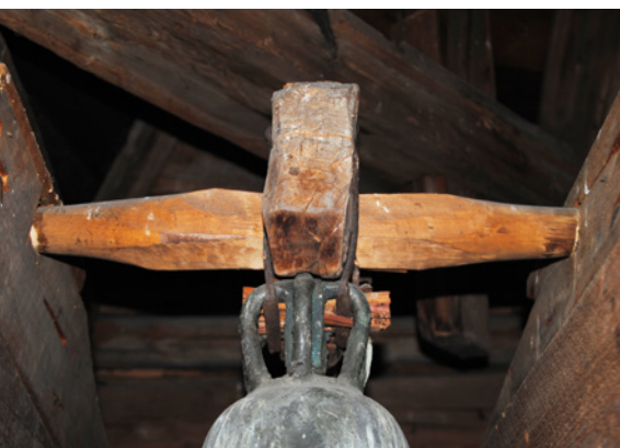
Ill. 9: Bruflat kirke, Oppland. Dette opphenget er utelukkende i treverk og har først og fremst historisk og teknisk verdi. Mangelen på aksel av stål gjør at klokker med denne typen oppheng må ringes svært forsiktig. FOTO: TERJE DE GROOT.
