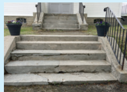
Behov for vedlikehold av trappen utenfor Rud kirke
