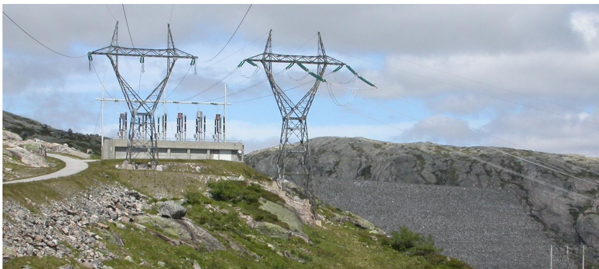
Svartevannsdammen i Sirdal Foto: Fylkesmannen i Vest-Agder
