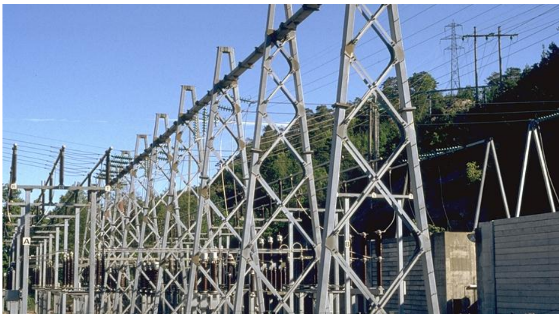
Strømforsyningsanlegg Agder Foto: Fylkesmannen i Vest-Agder
