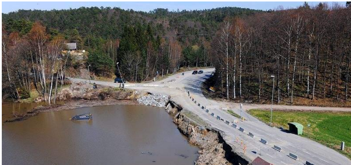
Kvikkleireskred ved Kjærtingland i Lillesand Foto: Agderposten
