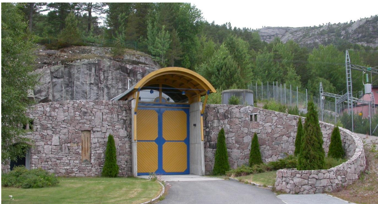
Inngangen til nye Skjerka kraftstasjon i Åseral Foto: Fylkesmannen i Vest-Agder
