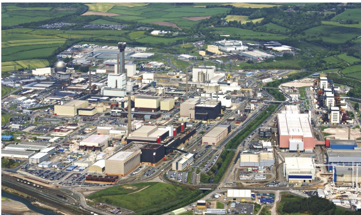
Sellafieldanlegget i England Foto: Sellafield Ltd
