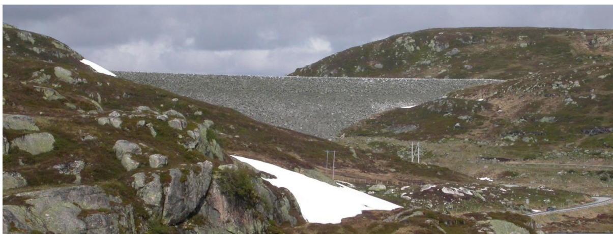
Dam Rosskreppfjorden Foto: Fylkesmannen i Vest-Agder
