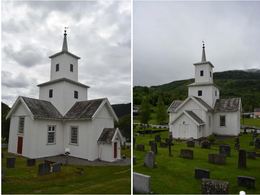
Tuddal kirke før og etter påbygg av nytt våpenhus
