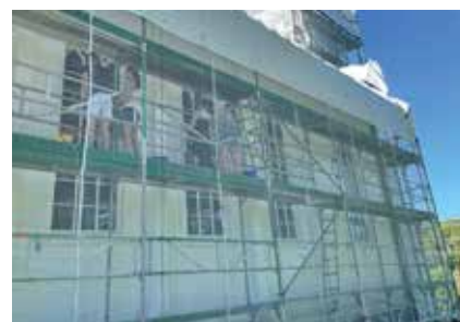
Vasking av vinduene før stillaset tas ned
