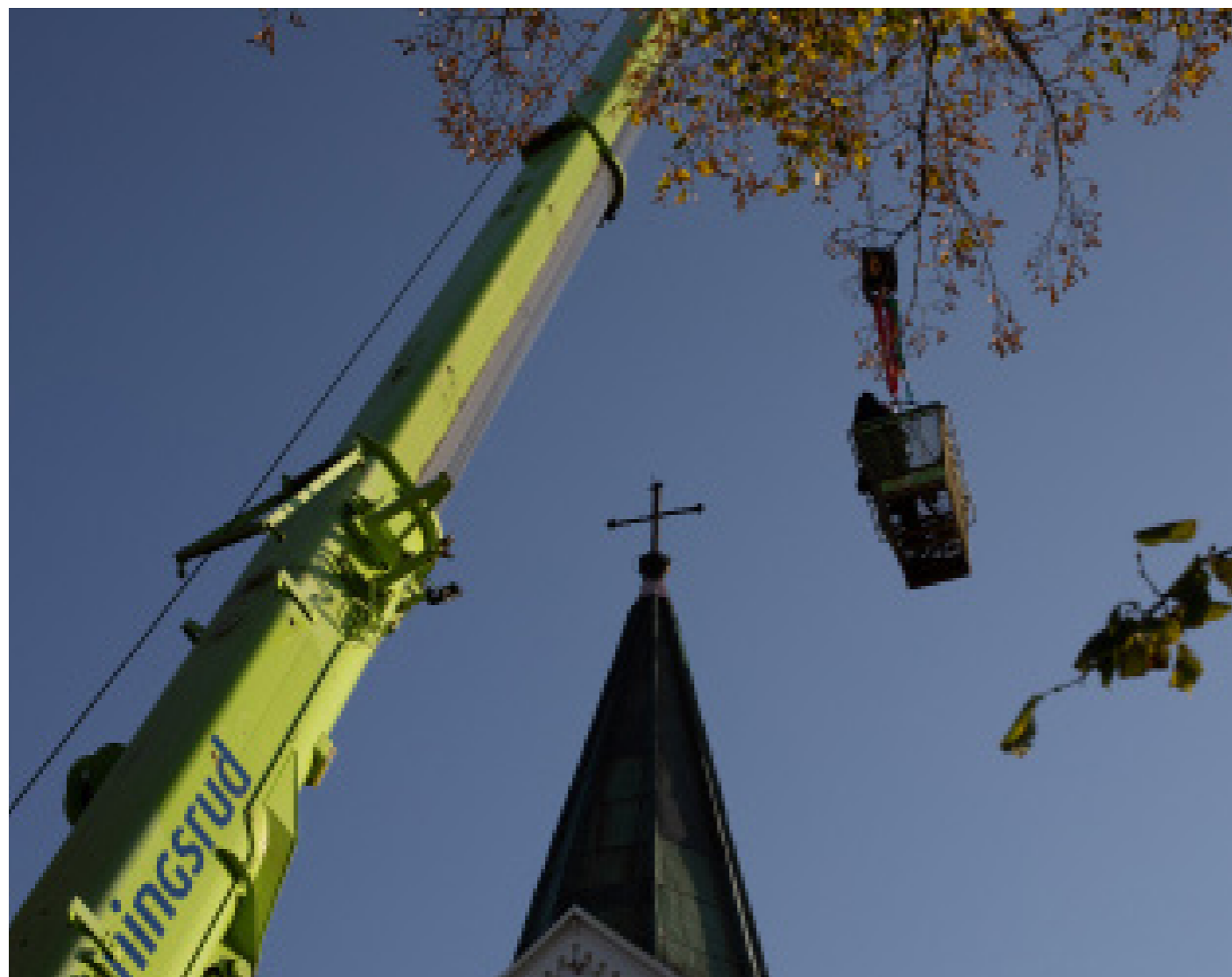
Stor kraner måtte til da kobberplater måtte skiftes ut øverst på kirketårnet i Hurum kirke
