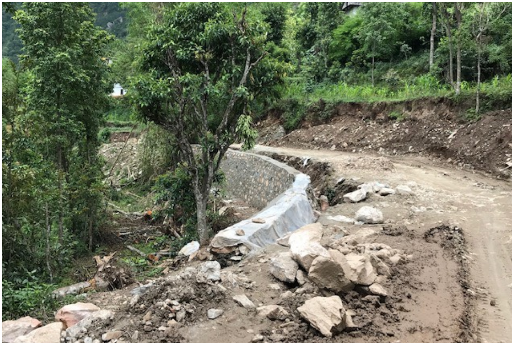
Vägbygge med uppmurning av stödmur för att vägen ska hålla även under monsuntider
