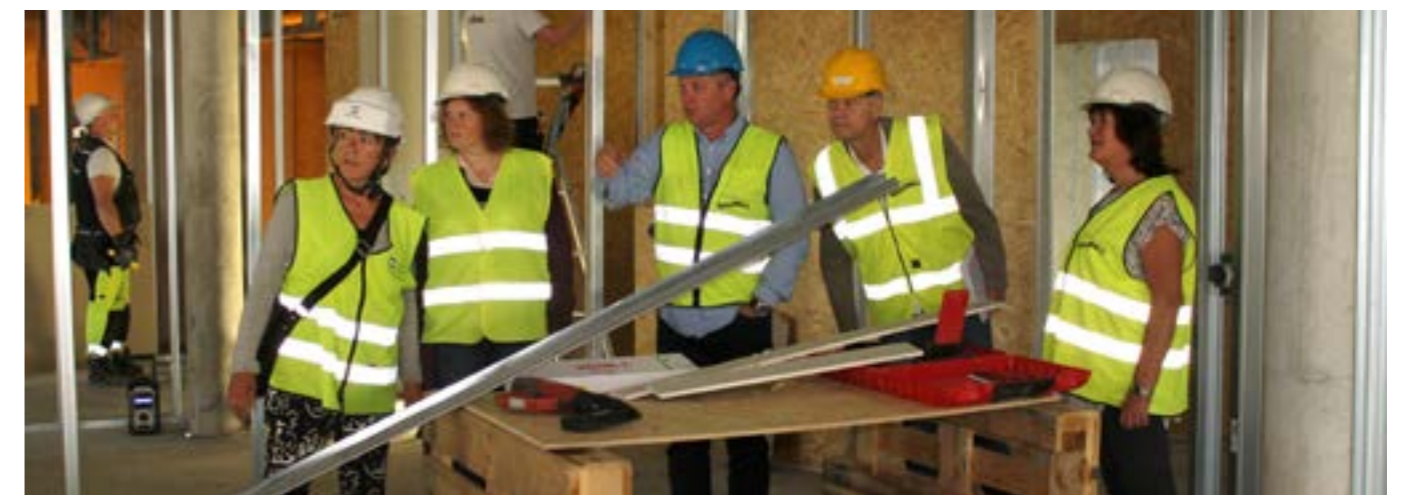
Befaring i den nye kjelleretasjen. Fra venstre: Kommunearkitekt Ingunn Ramsfjell, kulturhussjef Garbara de Hahn, driftsjef i Asker kirkelige fellesråd Even Frogg, kirkesjef John Grimsby og daglig leder Kari Sorknes på befaring i kjelleren i Vardåsen kirke. Lokalene skal stå ferdig i løpet av september
