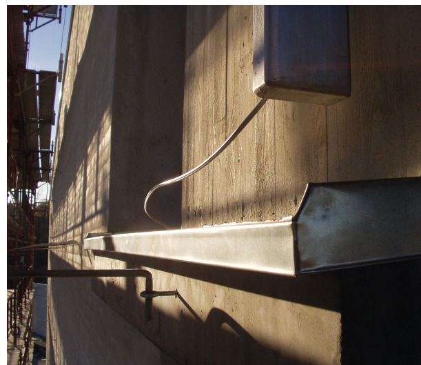
Ved foten av korset i kirkens tårn er det etablert en ledning med jording som tjener som lynavleder for kirken. Det er vanskelig å arrangere en test på om denne fungerer som den skal, men det har så langt ikke vært noe lynnedslag i kirken. Jeg liker å tenke på korset som en lynavleder for ondskapens makt.
