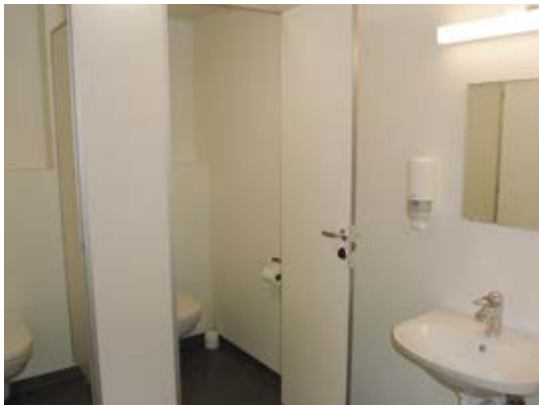
Dei svært så nedslitne toalettromma er fullstendig rehabiliterte. Her er støypt nytt golv, og alt av sanitærutstyr er nytt. Ein har også fått tilpassingar til universell utforming.
