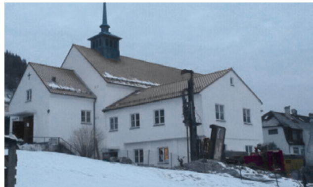
Boring etter jordvarme til Solheim kirke.
