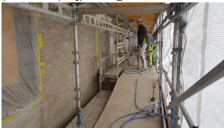
AVSLUTNING KALKPUSS ARBEID PÅ SIDESKIPET I SØR.
