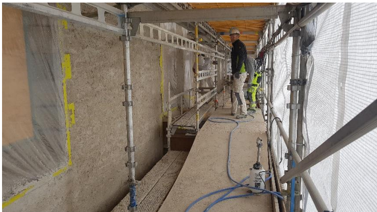
AVSLUTNING KALKPUSS ARBEID PÅ SIDESKIPET I SØR.
