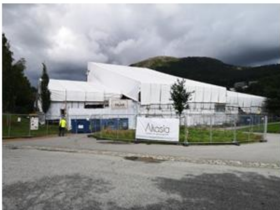
Fyllingsdalen kirke innpakket i plast
