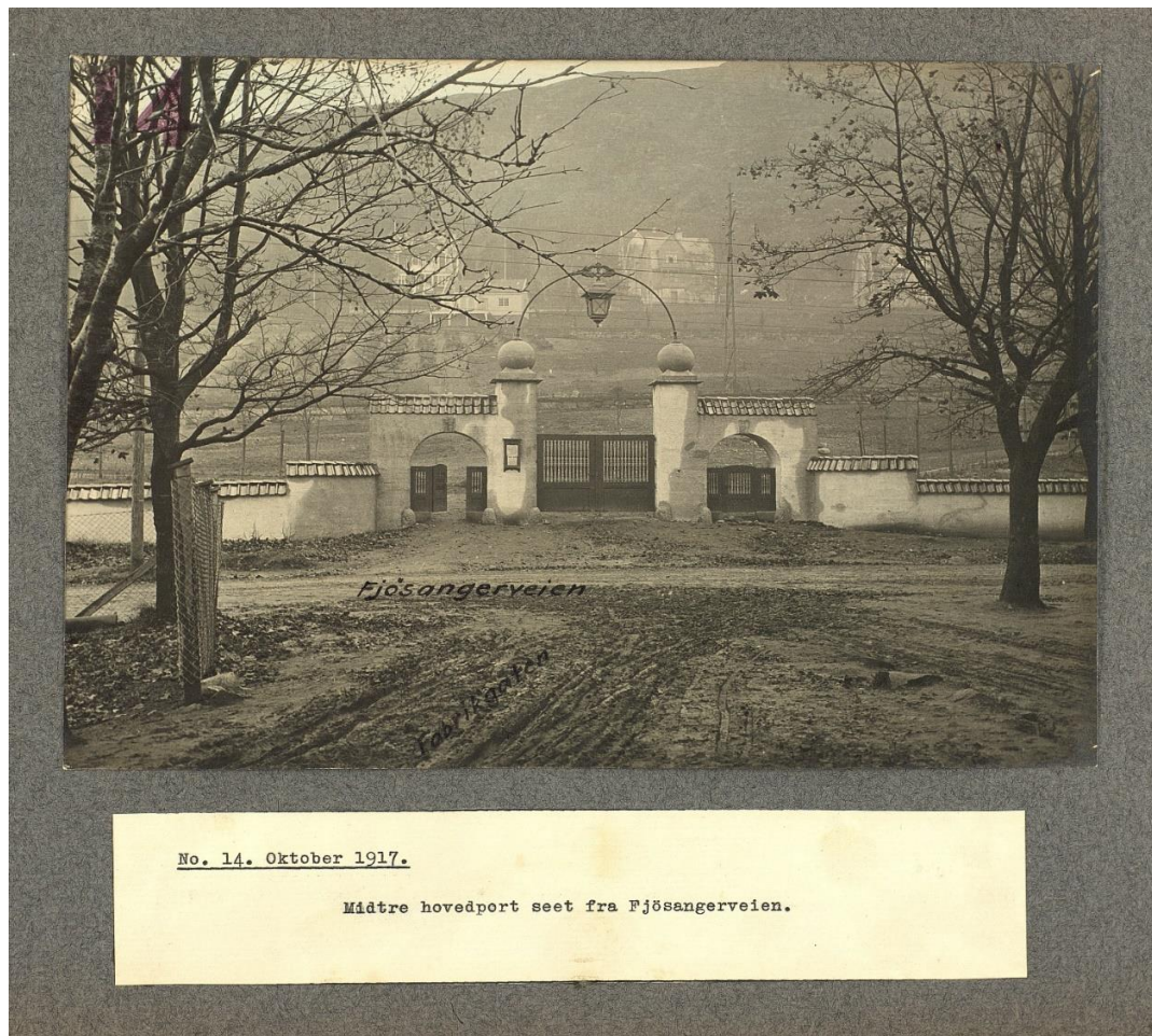
Vedlegg 1 – Opprinnelig midtre portal
