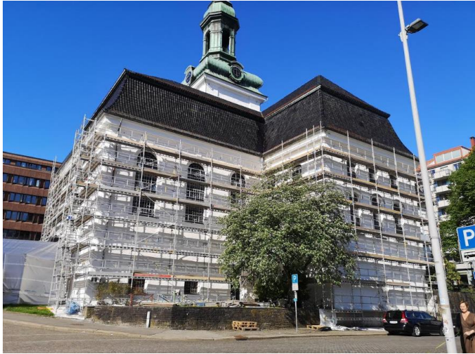
Utvendig rehabilitering av Nykirken – behovet var stort. En del nødvendig takarbeid er utsatt til seinere år, i påvente av nye statlige bevilgninger
