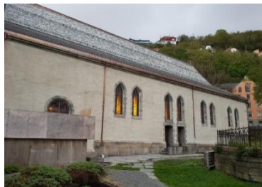
Tak og kalkvegger på Domkirkens skip ferdig
