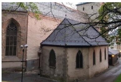
Nå starter arbeid med Skrudhuset
