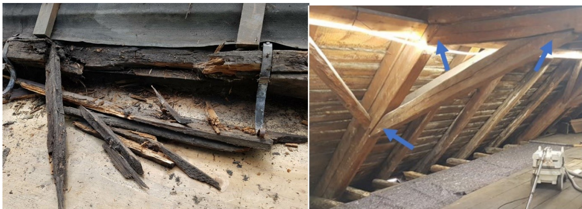
Figur 2, Utglidning av hovedsperrebind A.
