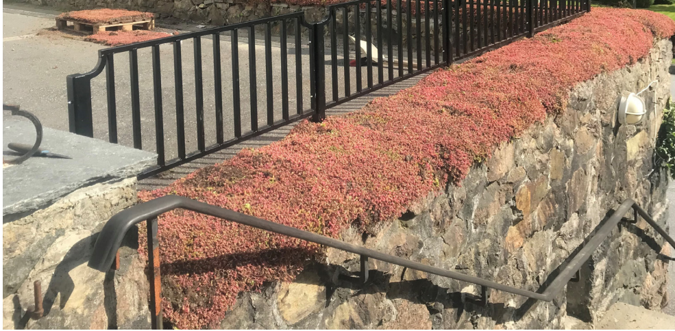
Nytt gjerde og beplantning med muren til Salhus kirke er kommet på plass. Foto: Salhus menighet
