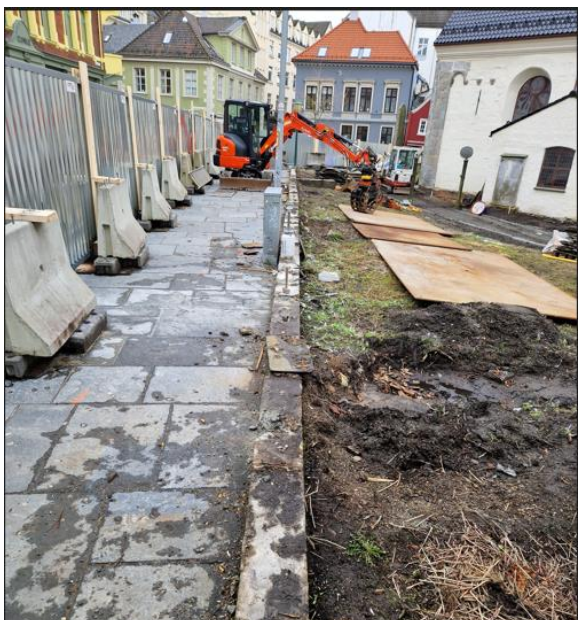
Gjerdet mellom Korskirkegården og Kong Oscars gate er tatt ned for å få bygget ny mur. Det gamle gjerdet skal så remonteres.
