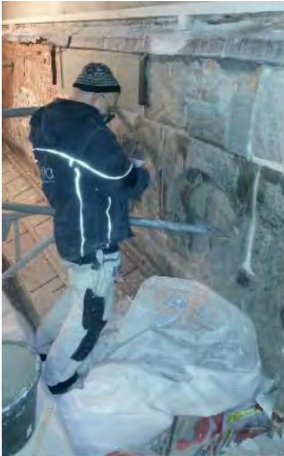
Pinning og kalking av veggdetaljer har foregått under varmetelt i vinter. Vi forventer at alle vegger utenom tårnet vil bli kalket i løpet av 2018.
