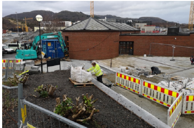
Bygging av nytt inngangsparti til Åsane kirke.
