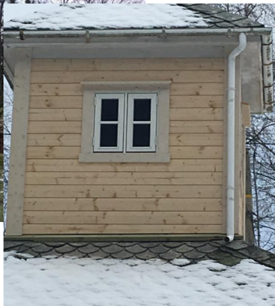
EIDSVÅG KLOKKETÅRN - ETTER
