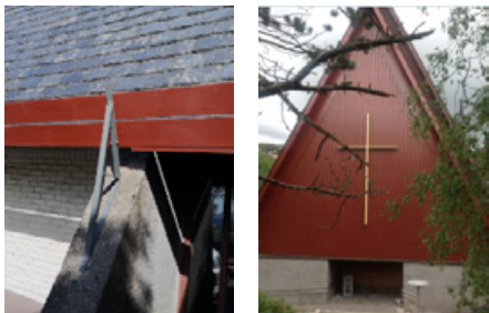
T.v.: sikring mot fallende takstein, T.h.: frontveggen i Biskopshavn kirke er forsterket og fornyet.
