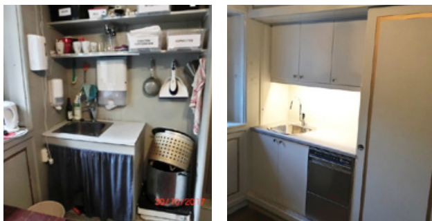
Sakristi i Fana kirke – før (venstre) og etter oppussing (høyre).
