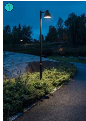
Referansebilde: Godt avskjermnet mastarmatur gir funksjonslys til gangvei med asymmetrisk optikk.
