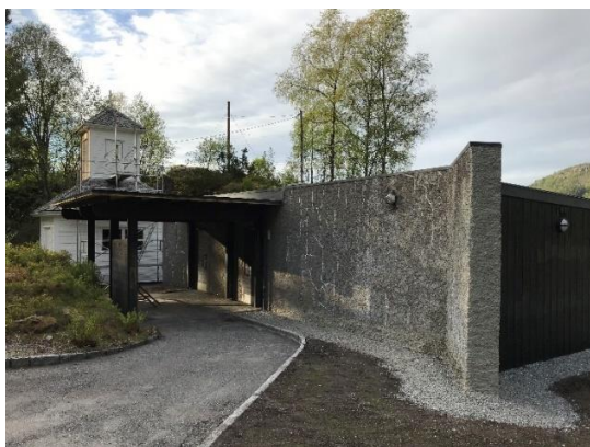
EIDSVÅG – Mur til tørk før maling
