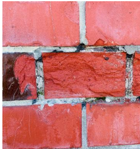
Bilde 23, Frostskadet glasert tegl
