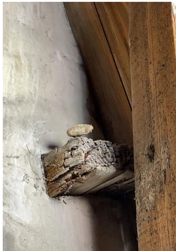
Bilde 38, Sopplegema i råttan trebjelke (sørside tårn)
