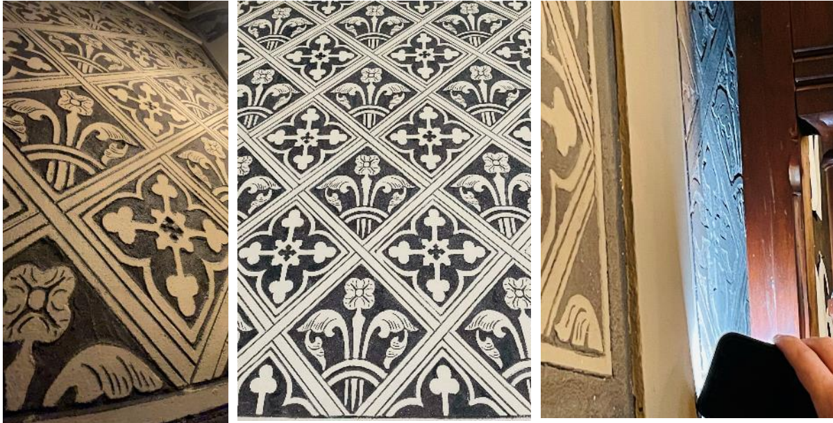
Bilde 14, En illusjon av Sgraffitto. Bak altertavlen vises umalt dekor i relieff. De lavtliggende feltene har blitt malt med kalkmaling etter montering av nummertavlene.
