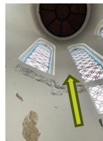
Bilde 52, skader forekommer i hjørner, under beslag, og i overgang tak/vegg. Bildet til høyre er tilsvarende sted som bildet til venstre (farge på pil indikerer tilsvarende sted)
