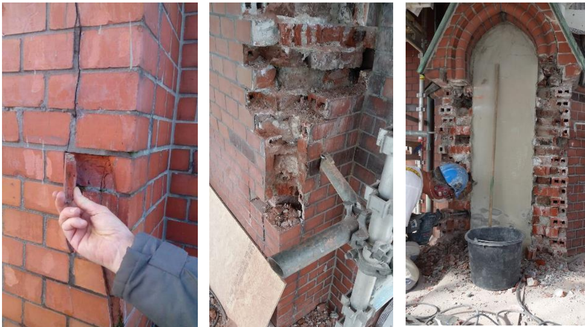
Bilde 17, Bilder fra rehabiliteringen i 2015. Tegl sprenges, og større partier plukkes ned.
