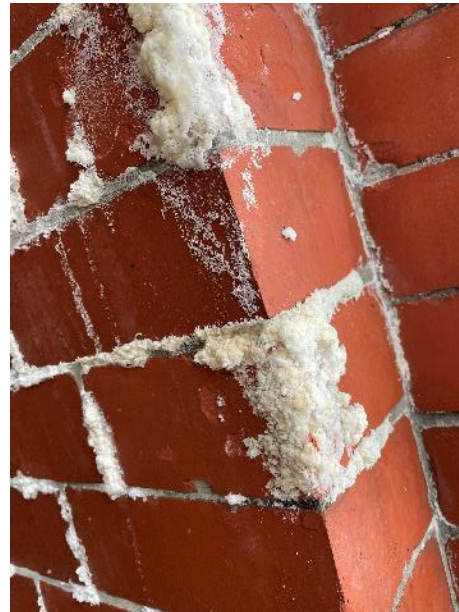
Bilde 41, Fuge fra portal. Hvitt «skum» er saltutfellinger. Grått innerste sjikt (1) er murmørtel, sortpigmentert (2) er original spekkemørtel, det ytterste sjiktet er nyere upigmentert spekkemørtel (3). Bildet til høyre viser saltutfellinger i fuger og på tegl i samme portal.
