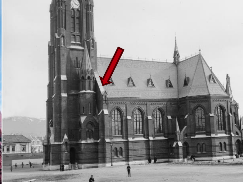
Bilde 60, Antatt 1910. Det er benyttet kalksteinskifer (tavleskifer også på gesims. Mellom skip og tårn. Denne er i dag erstattet med kobber.
