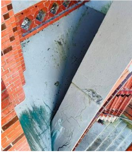
Bilde 27, Støpt betong over våpenhus
