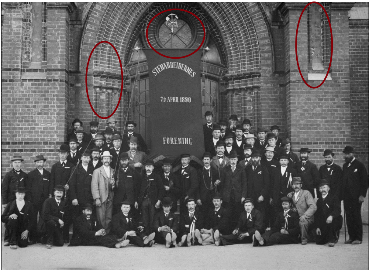
Bilde 15, Antatt fra senhøst 1893 eller vinter 1894 etter ferdigstilling av murverk og før innsetting av blyglassvinduene. Legg merke til saltutfelling og skader i pussfelt og tilløp til saltutfelling i murverket (røde markeringer). Vinduet over porten er ikke installert og det er grunn til å tro at dette bildet er tatt våren 1894, før innvielse.
