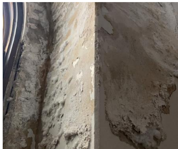
Figur 30, Saltutfellinger inne i trappetårn på sør-østre side av skipet. Saltene har felt ut på utsiden av den kapillærsugende og dampdiffusjonsåpne malingen. Slike salter kan i prinsippet kostes bort da de ikke har gjort stor skade på pussen. Disse feltene kan være egnet til hampkalk.
