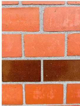
Figur 32, Skifthyden er 77 mm og skiftlengden 130mm. Det er benyttet 1/4 og 1/2 stein i forbandt. Innmurt i fortanning med bakmur.
