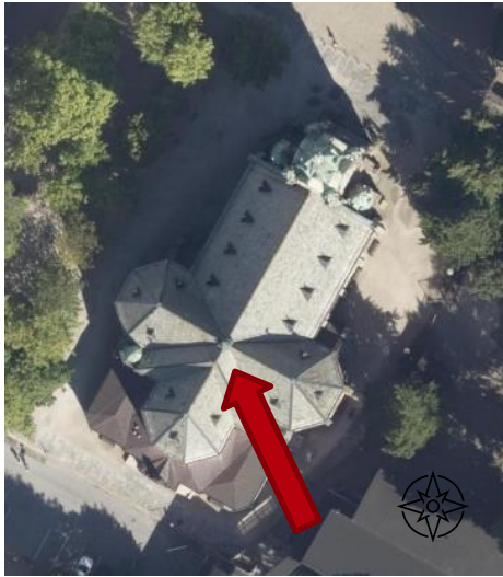
Bilde 2, Oversiktsbilde av Johanneskirken orientert i forhold til himmelretning. Rød pil viser dominerende vindretning. Hjørnet på tårn mot sør-øst viser størst skader, se pil. (1881.no, 2023)
