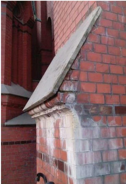
Bilde 35, Kalkutfellinger fra betongstøp (Akasia, 2015)
