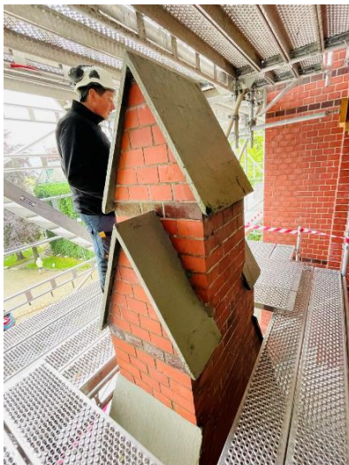
Bilde 56, Betongtak over portal
