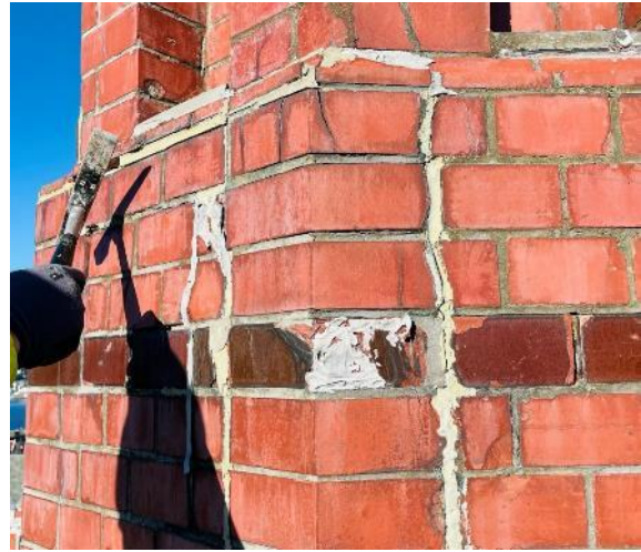
Bilde 62, Slik utbedring er ikke anbefalt
