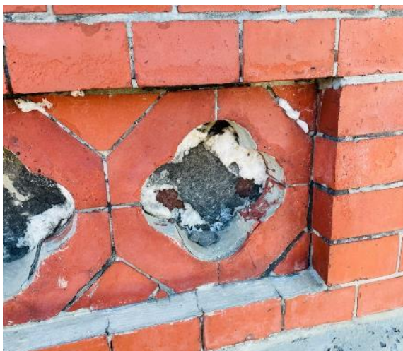
Figur 29 Massive og sterkt krystalliserte saltutfellinger på utsiden av kirken i ornamenter. Saltene penetrerer gjennom de mer kapillærsugende fugene og i pussen. Sementslørret på teglflatene kan indikere at det å forhindre vann utenfra vil gi en positiv effekt. (Fra tårnets nordøstre fasade)
