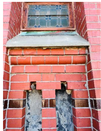
Bilde 44, Sementpuss fra fordybninger har minst 4 sjikt. Pusslag 1 (eldst) er pigmentert med sort pigment (jernoksid). Pussen er bindemiddelrik, finkornet og består av store mengder sement.
