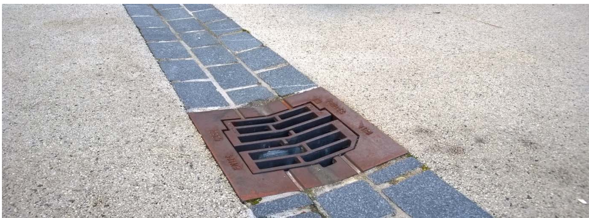
Bilete 6: Døme på kombinert ledelinje og vassrenne med 3x storgatestein og tilpassa gatesluk. (Frå Høgskulen i Bergen, foto: ML)
