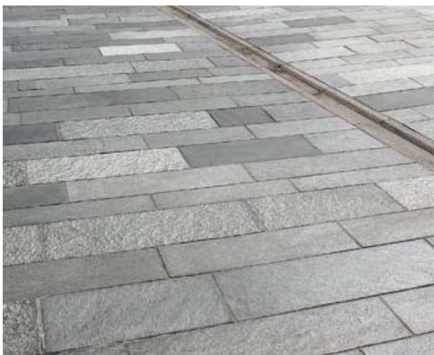
Bilete 7: Skiferdekket er tenkt i store, rektangulære heller med fallande lengder og ulike breidder, lagt i forbandt mønster (døme til venstre er Oppdalskifer).
