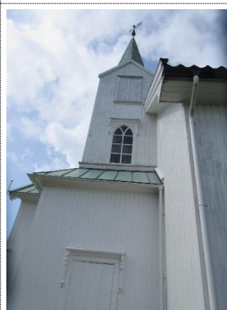
Bilde nr. 10 Tårn/spir er tekket med kobberplater av høy alder - fremstår hel uten synlige skader.
