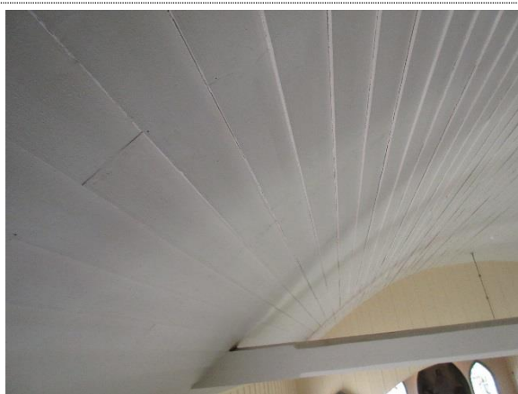
Bilde nr. 19 Panelt skråhimling i skipet.
