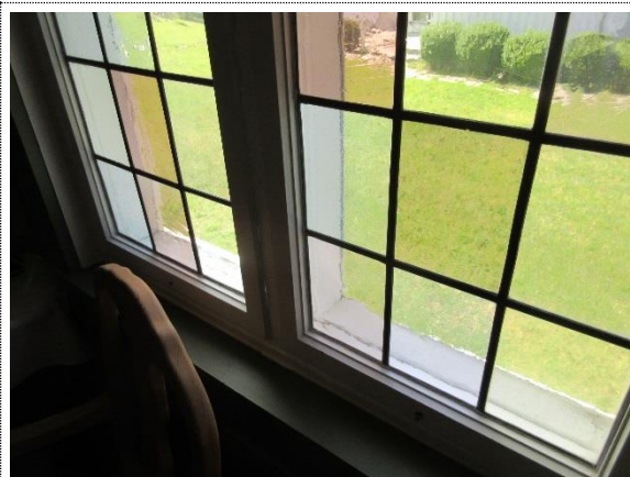
Bilde nr. 12 Innvendige varevinduer med blyglass satt i to-lags isolerglassruter.
