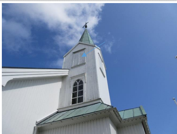
Bilde nr. 23 Kobbertekking på klokketårn/spir. Elektrisk opererte luker øverst.
