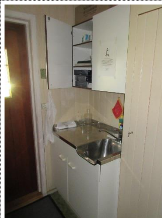
Bilde nr. 28 Også et lite kjøkken med oppvaskbenk.
