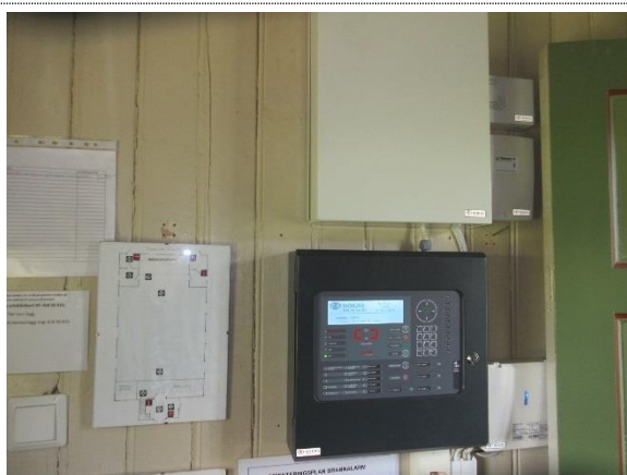
Bilde nr. 13 Innervegger med gammel stående panel. Her fra inngangen mot nord med bla. brannalarm-sentralen
