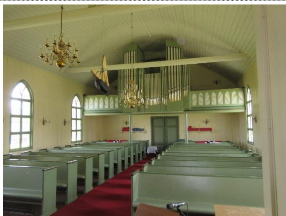
Bilde nr. 15 Fra skipet med panelte innvendige flater på vegger, gulv og himling. Mrk. synlig undergurt i taket.
