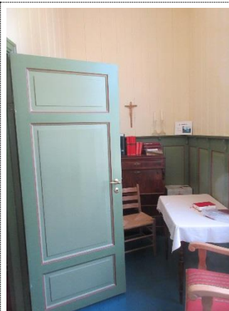
Bilde nr. 14 Det er brystningspanel i sakristiet.
