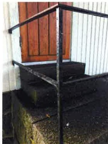
Rekkverket vaskes - slipes grundig. Rust fjernes til bart jern. Bart jern flekk males med Zinga sinkmaling og males 2 strøk med Bengalakk.
