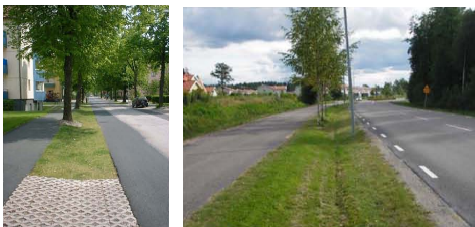
Figur 1 Eksempel på gresskledd filtergrøfter langs gater (foto. Goran Lundgren)
