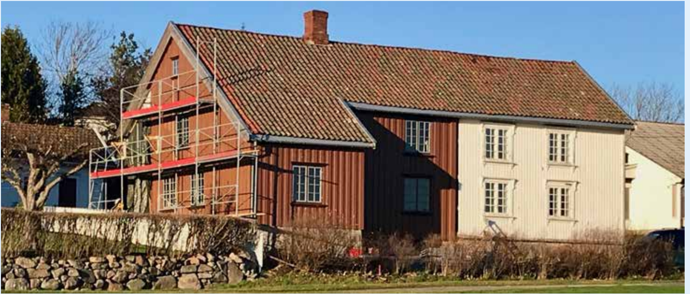
Barndomshjemmet til Hans Nielsen Hauge (1771-1824) har fått ny kledning, og vinduene er restaurert.
