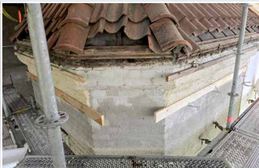
Kalkpussarbeider pågår - all den gamle pussen er fjernet på tårnet.
