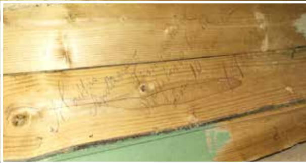
Et lite utvalg av eldre signaturer som var skrevet på takbordene helt oppe på toppen og inne i spiret, ved takluka.
