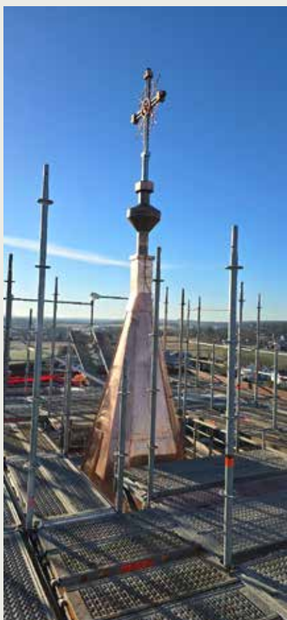
Det nye spiret i flott vær. Stillas på vei nedover. Toppen av korset står 38 meter over kirkebakken ved hovedinngangen.
