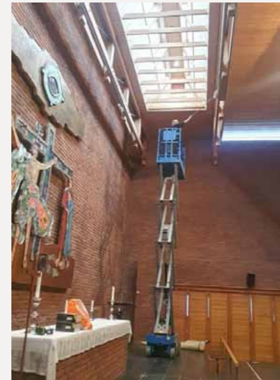
Skrekk og gru: I november måtte lyspærene i taket på Hunn kirke skiftes. Det var lift og full HMS-pakke, men like fullt nervepirrende å gå i høyden. Vi noterer skrekk og gru i dagsregisteret.
