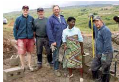
Sverre Stabell, Arne Stabell, Andrew Berge, Rachel (læreren) og Sverre Halvorsen like før grunnmuren var ferdig.
