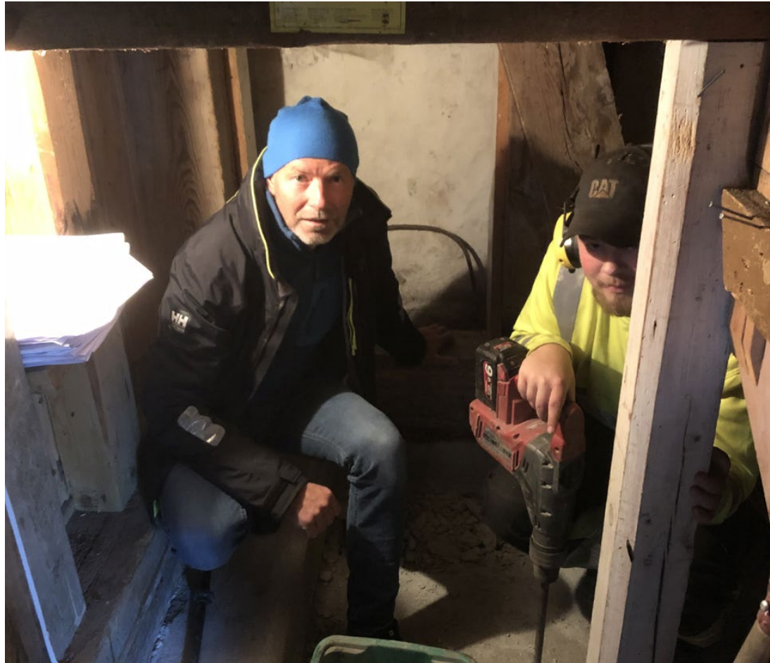
TRANG ARBEIDSPASS: Erik Nielsen sammen med en av montørene under trappa i våpenhuset, der sprinklersentralen skal ligge.
