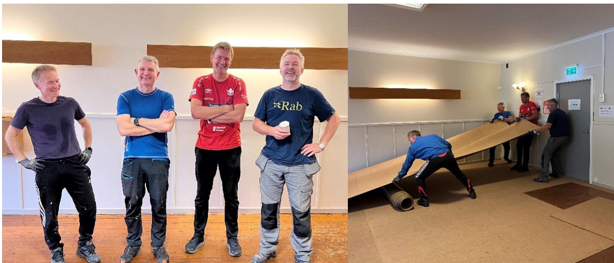
DEN YNGRE GARDE I SVING: Frå venstre Paul Magne Worren, Trond Welle, Bård Grimstad og Rune Pilskog, reiv ut det gamle golvbelegget, sjaua, fjerna plater og tusenvis av småspiker – for å klargjere legging av nytt golv. Foto: Hareid sokn
