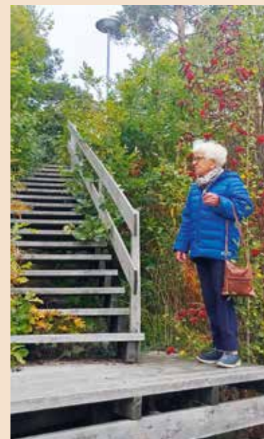
Torbjørng Ringdal viser en litt overgrodd stiltrapp-snarvei ned til Tinnheiveien retning Joker Tinnheia. Denne trenger vedlikehold for å unngå at spesielt eldre mennesker faller og skader seg.
