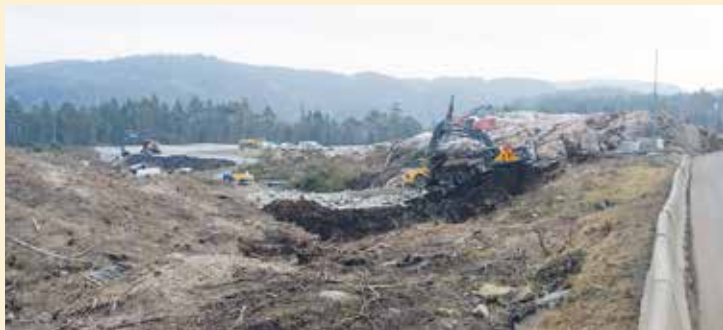
Nytt byggefelt i emning på Hellemyr. Her planlegges det 43 nye boliger, grøntområde og en offentlig lekeplass.
