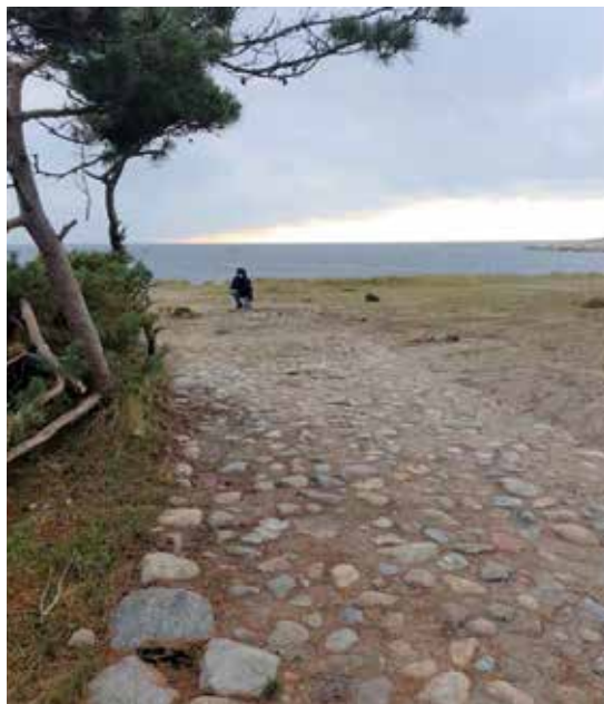
Tangveien slik den nå er avdekket gir et godt inntrykk av konstruksjonen. (Foto: Ruth Hemstad)
