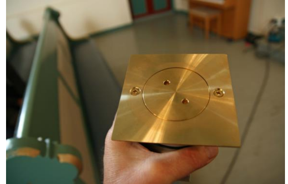
Ny koblingsboks for flyttbare benker
