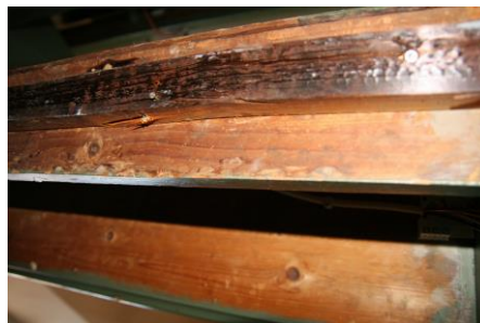
De gamle rørovnene kunne få en ekstrem overflatetemperatur
