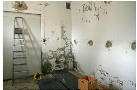
I bårerommet ble det pusset og malt
