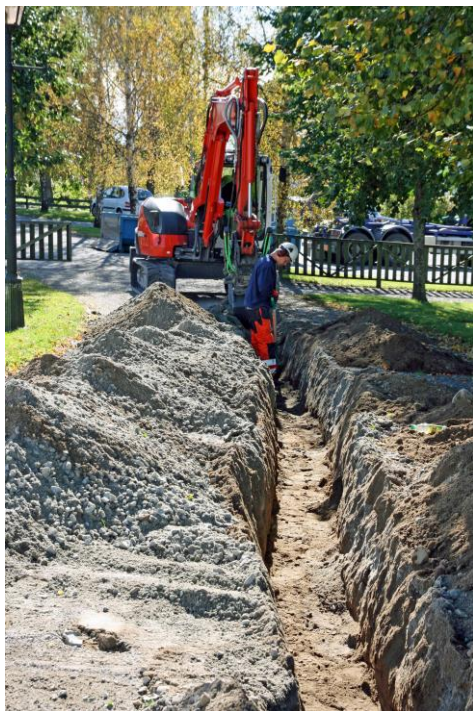
Grøft for ny kabel
