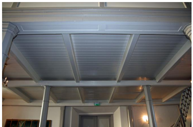
Galleriet må forsterkes for å tåle et orgel på ca. 2,5 tonn
