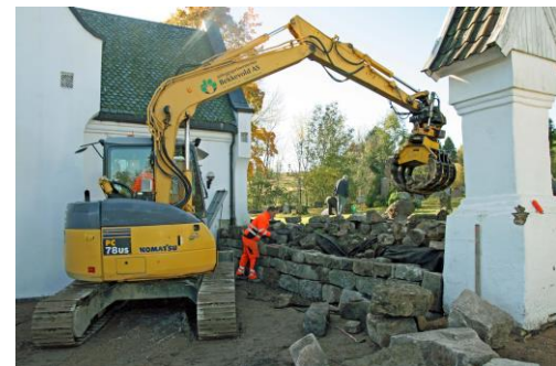
Gravemaskin med klype gjorde arbeidet lettere nå enn den gangen man satte opp muren første gang.
