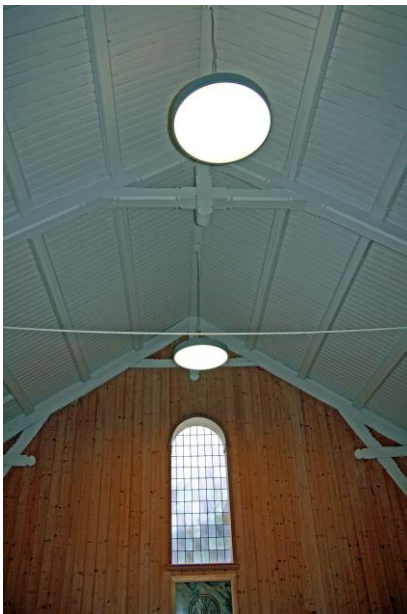
To nye taklamper montert i Sjøstad kirkestue
