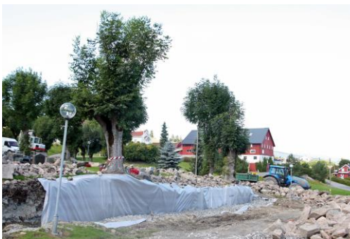
Vi la drenerende masser bak muren, i nedre kant la vi ned drensledning og fiberduk fra hovedporten og til kapellet.
