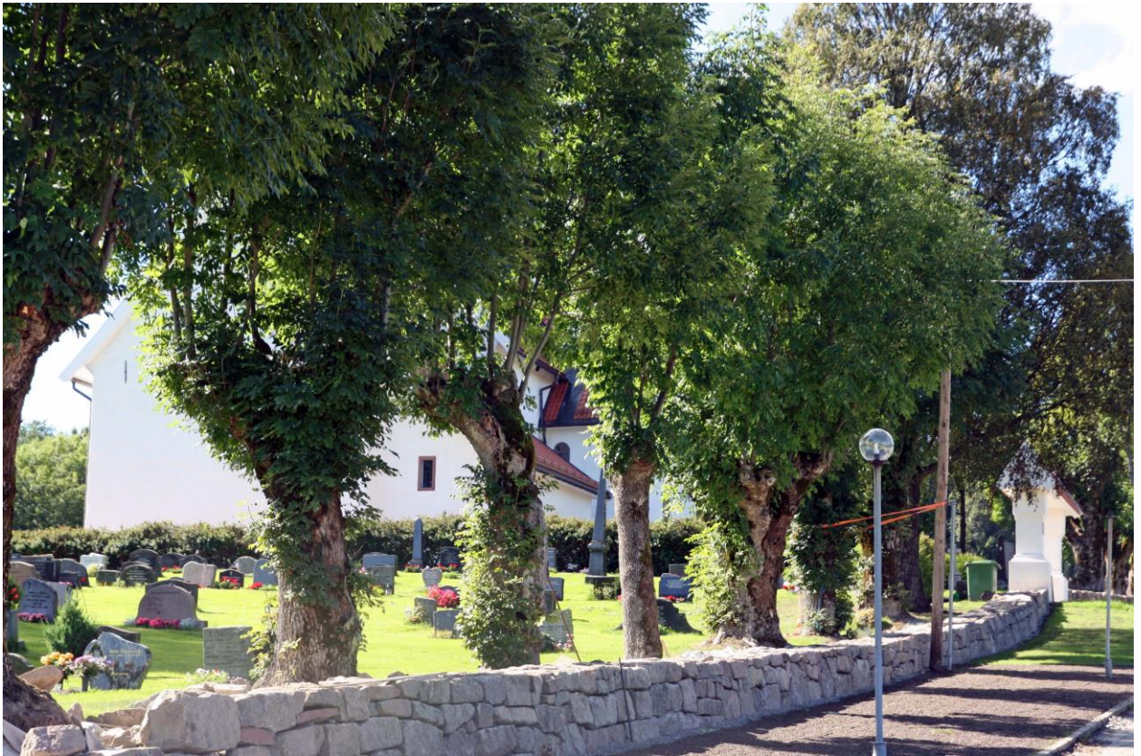
Arbeidet med steingjerdet v/Frogner kirke har vært et omfattende arbeid fordi vi hadde som målsetting å bruke mye av den gamle steinen på nytt. Noe tilkjørt stein måtte vi ha da en del av den gamle steinen var helt ubrukelig å mure med.
