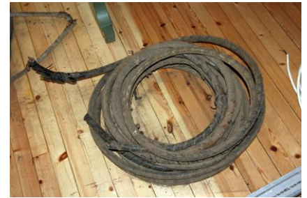
Gamle kuliokabler ble skiftet ut
