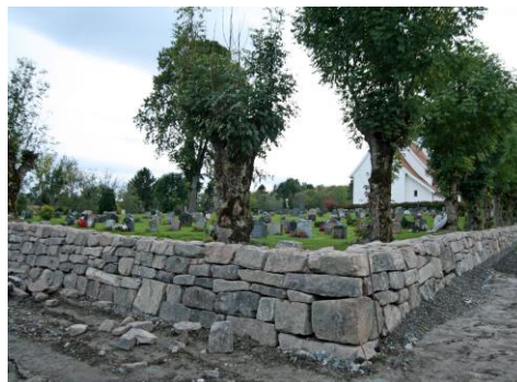
På hjørnet var det en gammel koblingsboks vi la under bakken for å få bedre retning på muren mot kapellet
