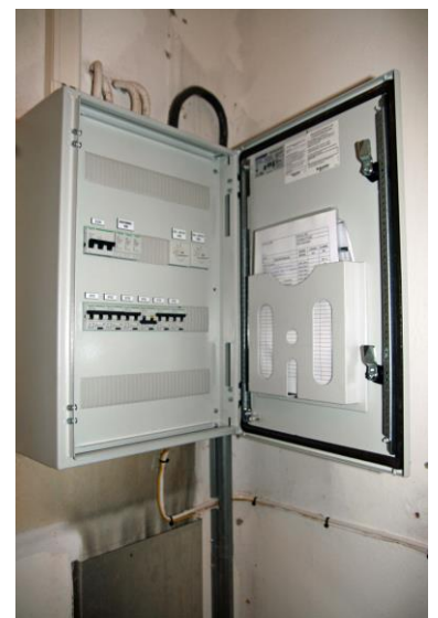
Nytt sikringskap i Tranby kapell
