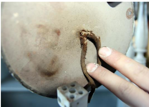
Gamle tøykabler ble skiftet ut
