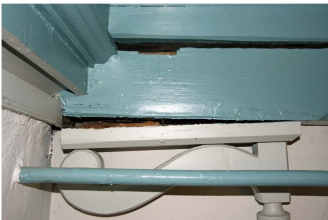
Råtten bjelke må skiftes
