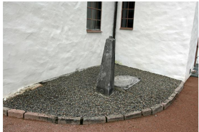
Ugress langsmed kirkemuren fjernet og erstattet med pukk
