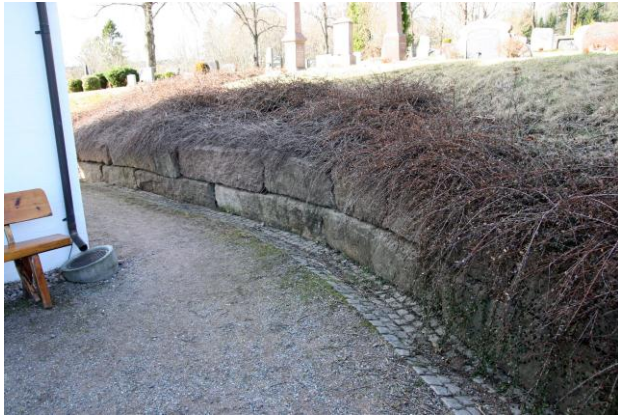
Granittmuren ved våpenhuset har gitt etter og begynner og helle utover i gangveien
