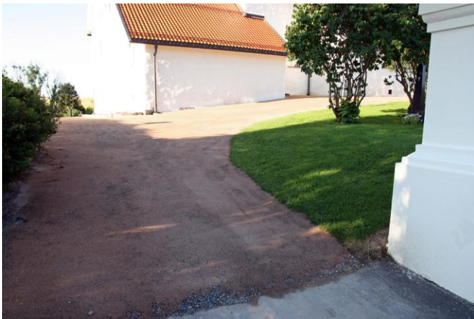
Gangveiene ble lagt om med knust asfalt under og rød subbus oppå
