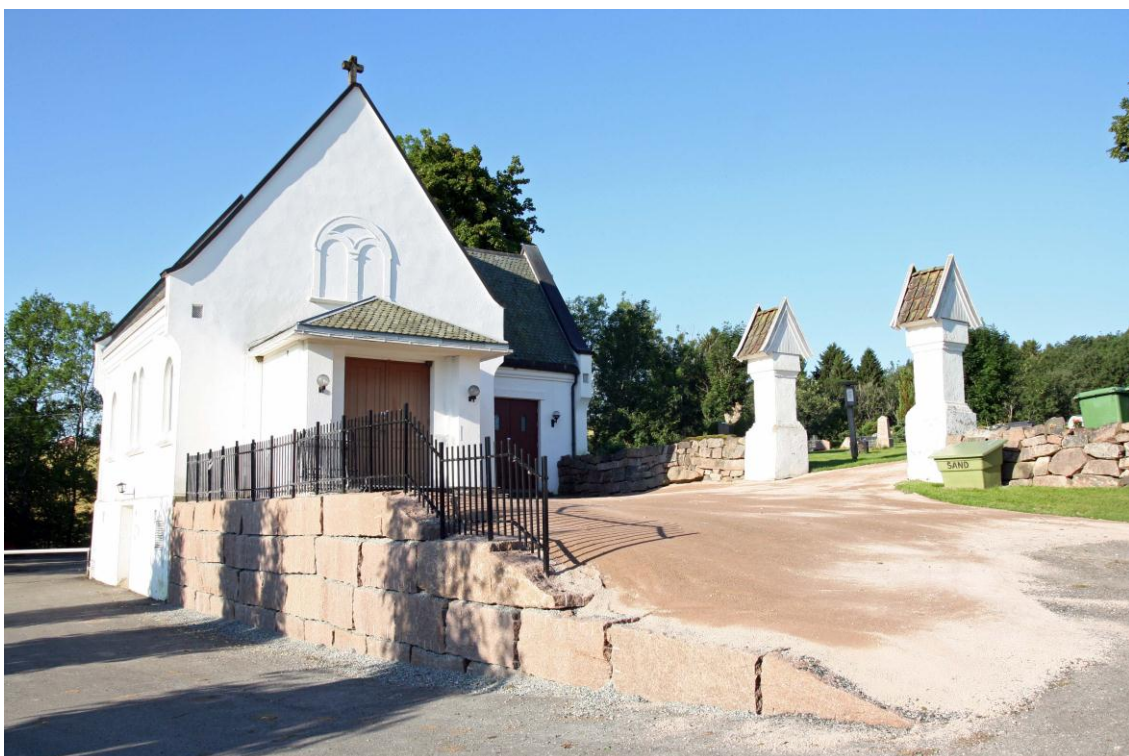
Ny mur til kapellet med rekkverk.
