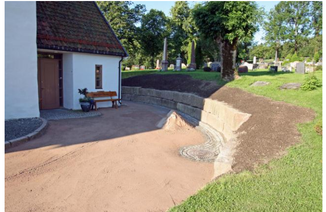
Muren ble tatt ned og bygget opp igjen. Firma: S.O.Transport
