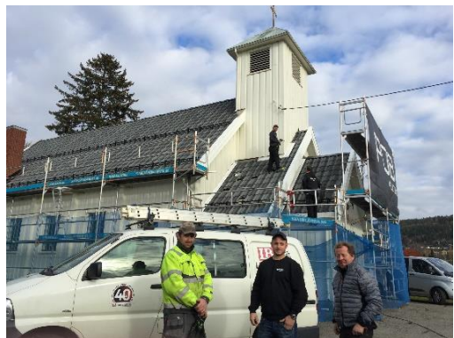
Gullaug etter skifte av tak
