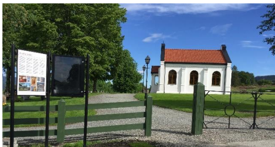
Tranby- ny port, nytt gjerde og ny informasjonstavle
