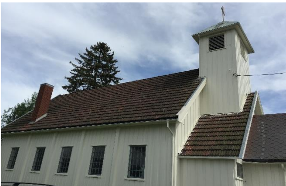
Gullaug før skifte av tak
