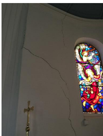
Sylling kirke – sprekk i murveggen
