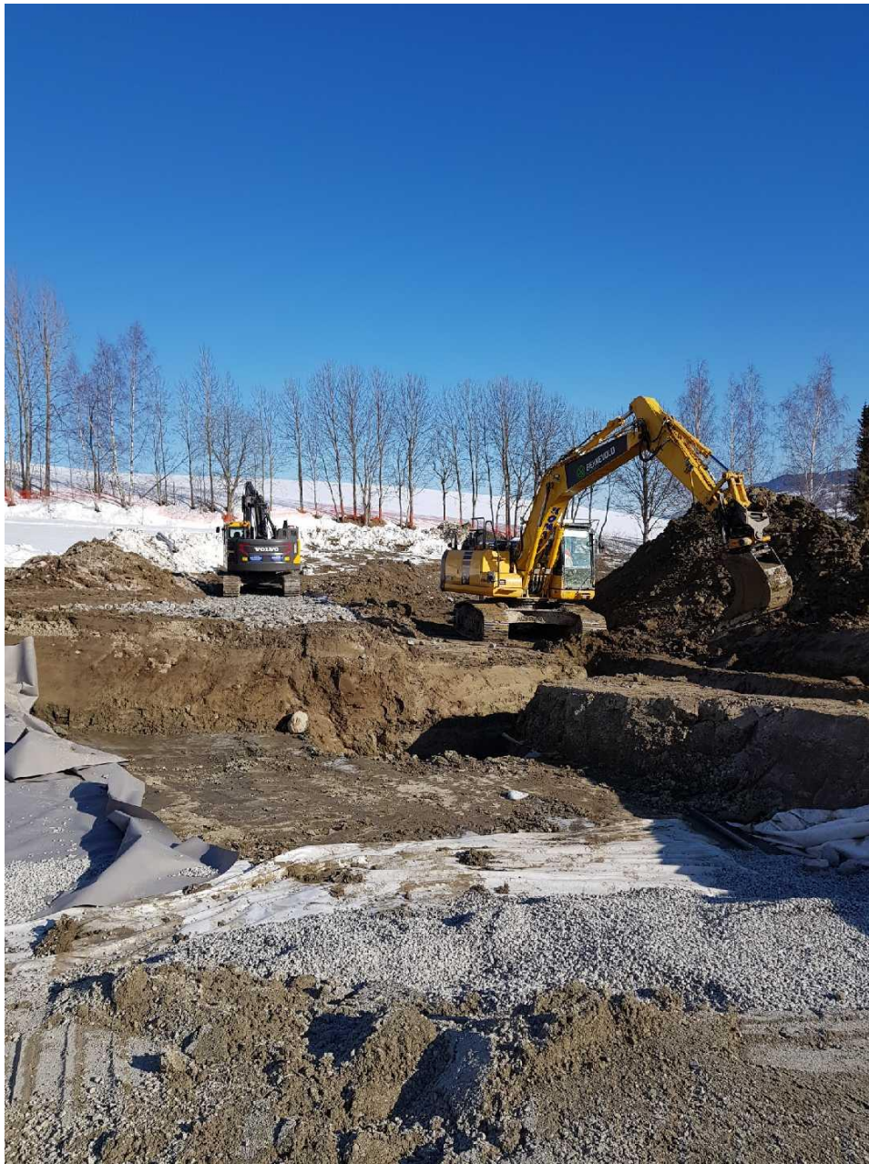
Utgraving for kistefelt 24 samt etablering av innkjøringsvei ved driftsplassen.
