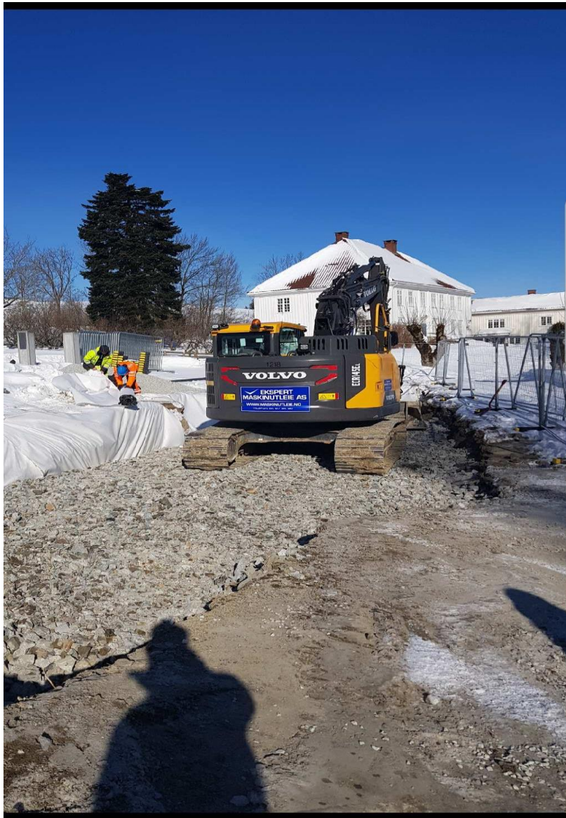
Kulting / utlegging av ny masse for mur ved minnelund.
