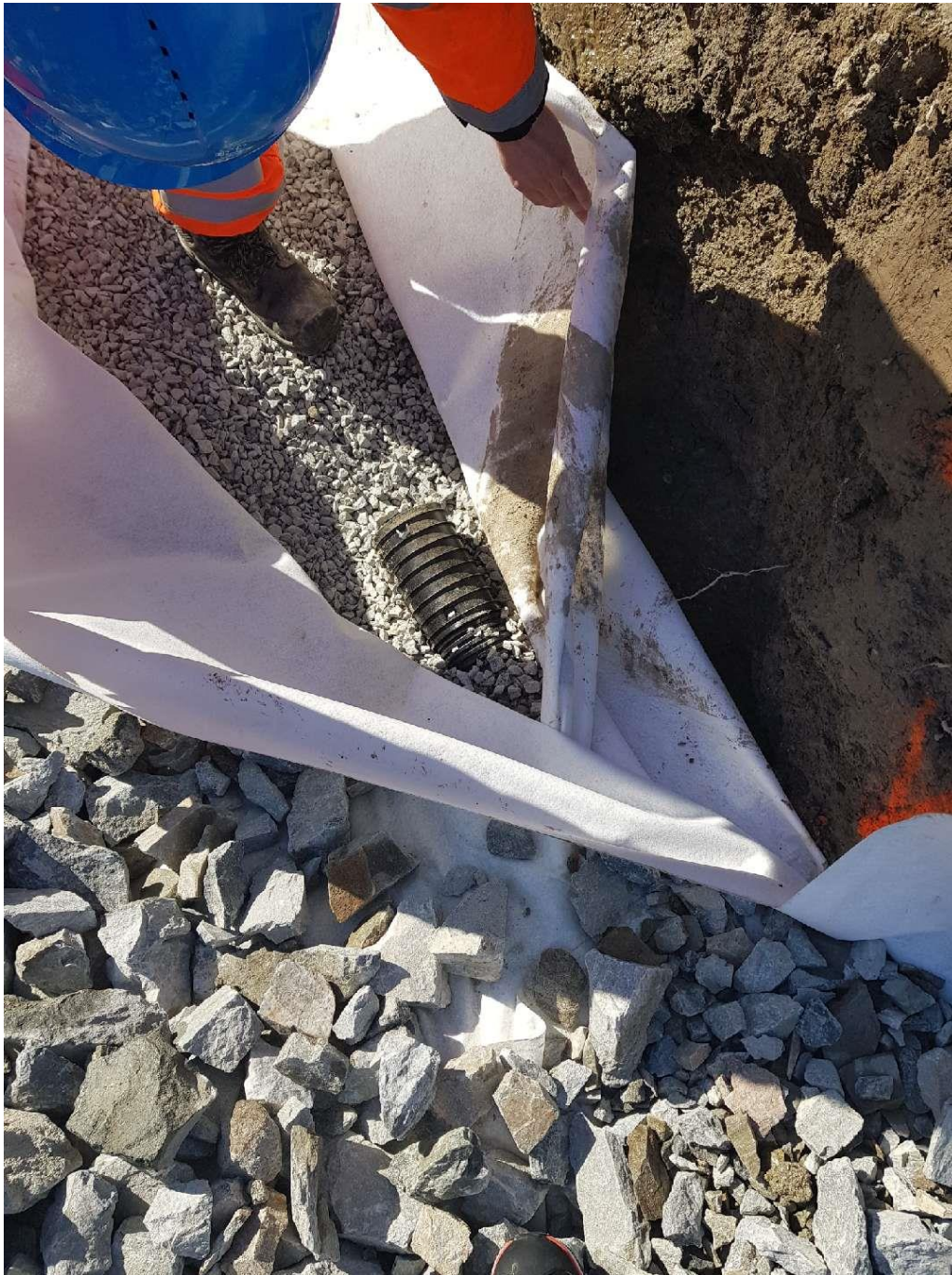
Kontroll av drensør, fiberduk, singel og maskinkult.
