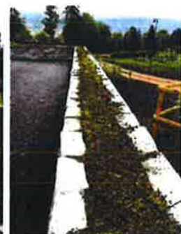
Sedum beplantet mur driftsplass
