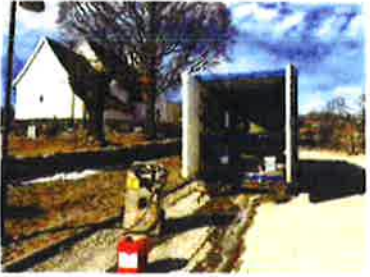
Vi gjennomførte styrt boring langs alleen, for å ivareta trærne
