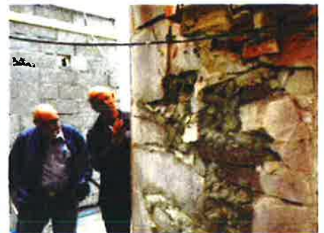
Ytterveggen vi måtte hugge igjennom var på over 1 meter.
