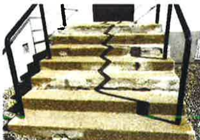
Lierskogen kirke - kjøkkentrapp
