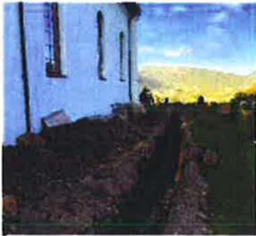
Ny vannledning ble anlagt ned til pumpekum og nytt WC
