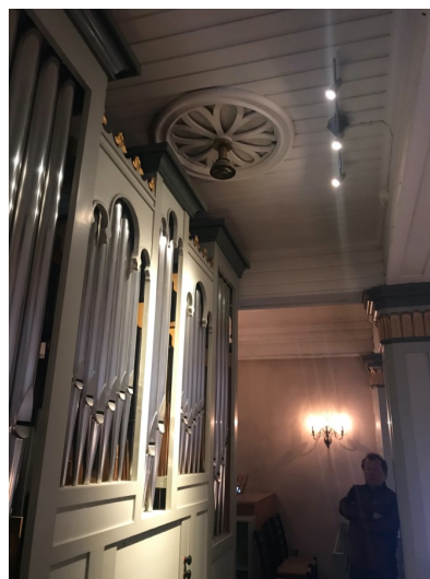
Lavvoltage halogen lyskilder i utenpåliggende skinner i himling galleri.
