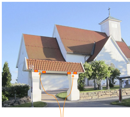
Armaturene plasseres i taket og lyser ned på front og innside av søylene
