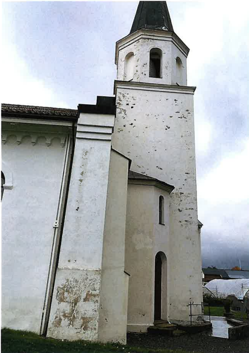
FIGUR 8. FLEKKVIS AVFLASSING OG FORVITRING AV ALL MALING INN TIL PUSSFLATE (SYNLIG SOM BRUNE FLEKKER). TÅRN OG VESTFRONTS NORDSIDE. (FOTO: KIRKEVERGEN 2018(?)).
