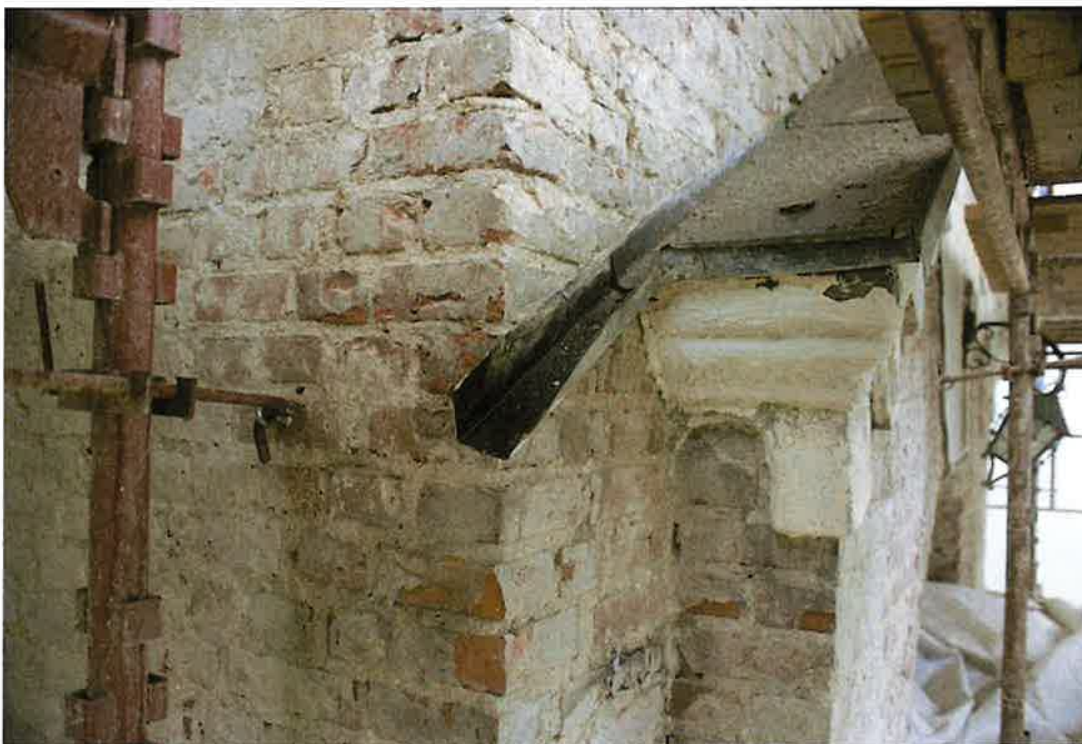
FIGUR 5. SITUASJON 2002: NORDVESTRE HJØRNET AV TÅRNET VISES MED FJERNET PUSS NED TIL OPPRINNELIG TEGL OG FUGER SOM FREMSTÅR SVÆRT LYSE/ TROLIG DE OPPRINNELIGE KALKFUGENE. (FOTO: RA V/ H. IBENHOLT 2002).
