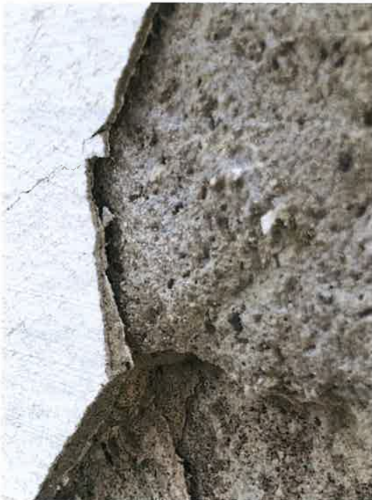
FIGUR 7. T.V. MANGLENDE VEDHEFT MELLOM FINPUSS OG GROVPUSS. YTRE SIKT ER SVÆRT BINDINGSSTERKT, OG INNTRENGENDE VANN HAR DERFOR VANSKELIGHETER MED Å FORDAMPE UT OG BLIR LIGGENDE BAK FINPUSSSIKTET. DETTE FØRER TIL FROSTSPRENGNING OG UTVASKING AV BINDEMIDDEL I DEN UNDERLIGGENDE MER KALKRIKE PUSSEN. T.H. ALLE VEGGENE HAR I MER ELLER MINDRE GRAD BOM I NEDRE 50 CM BELTE FORÅRSAKET AV KOMBINASJON MELLOM MYE FUKTTILGANG, TYKKE PUSSLAG OG BINDEMIDDELRIKE OVERFLATER. (FOTO: MUR OG MER, MARS 2021).
