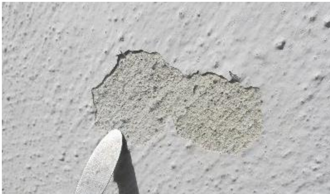
Fig.28: Frostskadet hvitning
