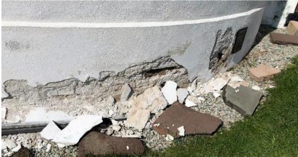
Fig.16: Sokkelen i apsisen har falt av mange ganger.
