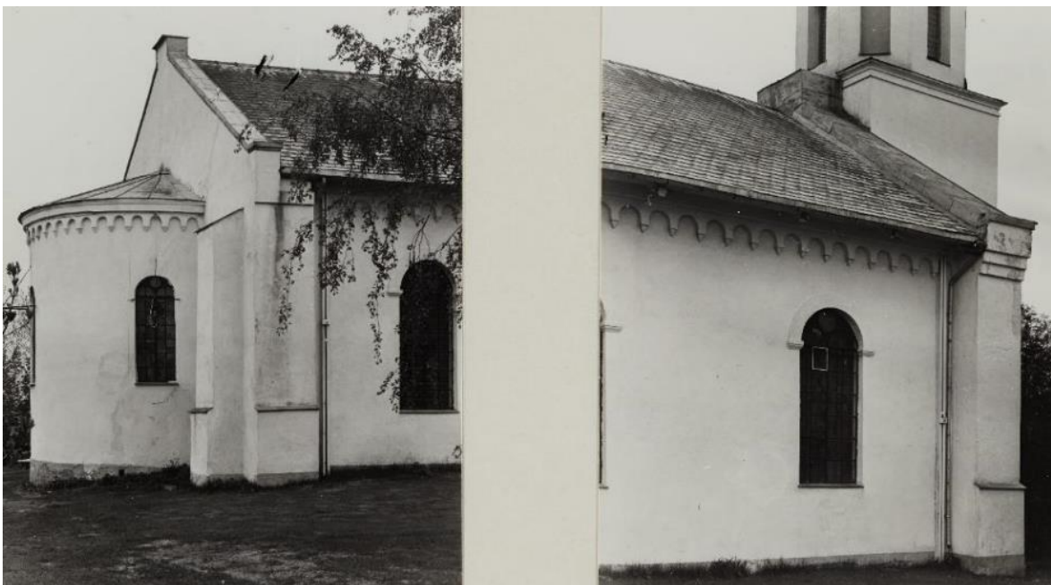
Foto 7: Apsiden sett fra nord i 1971 og nordveggen og tårnet fra nord i 1971. Taket har sementplater.
