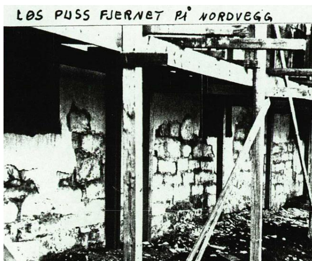
Fig.1: Omfang av delvis pussutskifting på nordvegg i 1956. Foto RA ved Cato Enger 1956.
