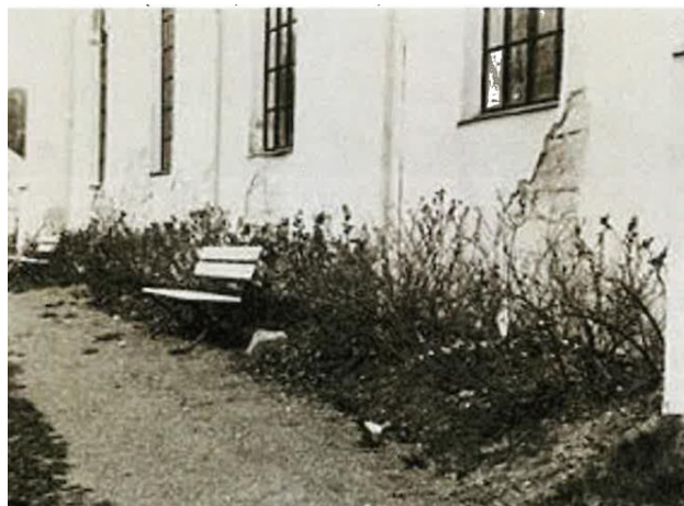
Fig.2: Bilde som viser hvordan pussen løsner på sørveggen i 1956. Pussen ble erstattet med «riktig» kvalitet.
