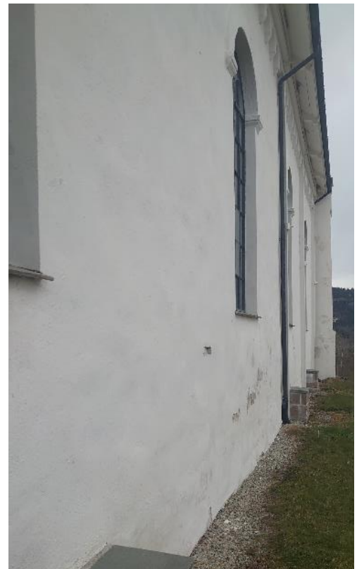
Fig23: S-veggen er ikke rett og nedre deler går lengre ut. Kalken flasser her.
