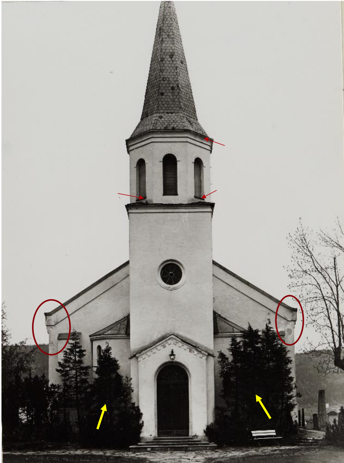
Fig 5: Vestfronten i 1971. Legg merke til trærne, fuktutslag i tårnet og skadene på hjørnelisenene mot sør og nord.
