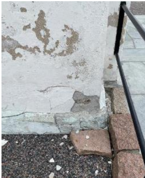
Fig.24: fukt og saltskader i hele nedre parti mot vest. Det bør legges inn mer helning utover og bedre avrenning.
