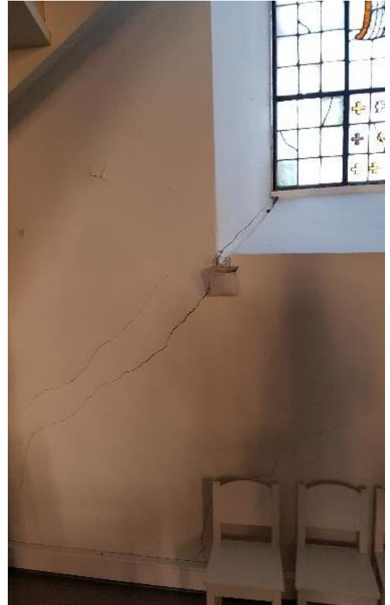
Fig.18: Sprekk på nordvegg under orgelgalleri.
