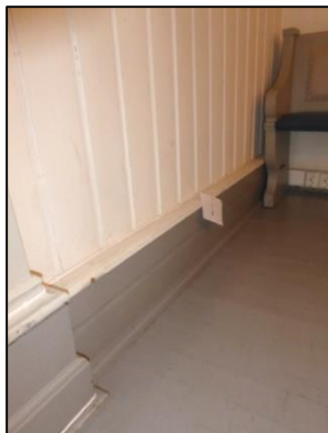
Vegg mot dåpssakristi fremme i skip
