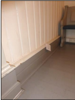
Vegg mot dåpssakristi fremme i skip
