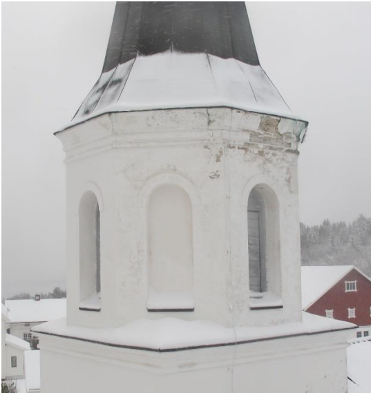
Bilder fra liftbefaring 23.11.22
