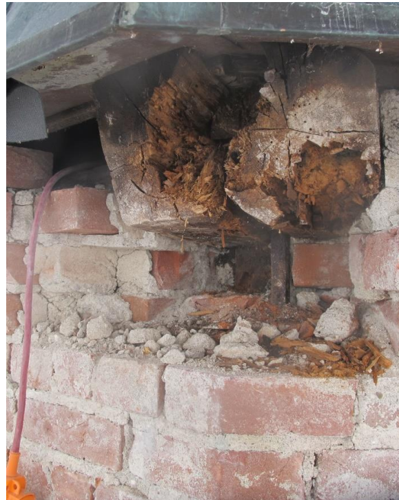
Sperre 7 fra utsiden.
